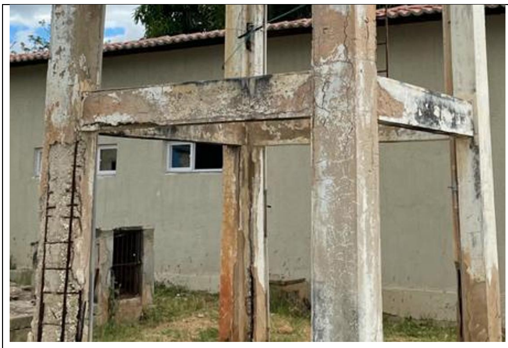
Figura 3 – Corrosão de armadura e deslocamento de concreto nos pilares e vigas do Reservatório.
