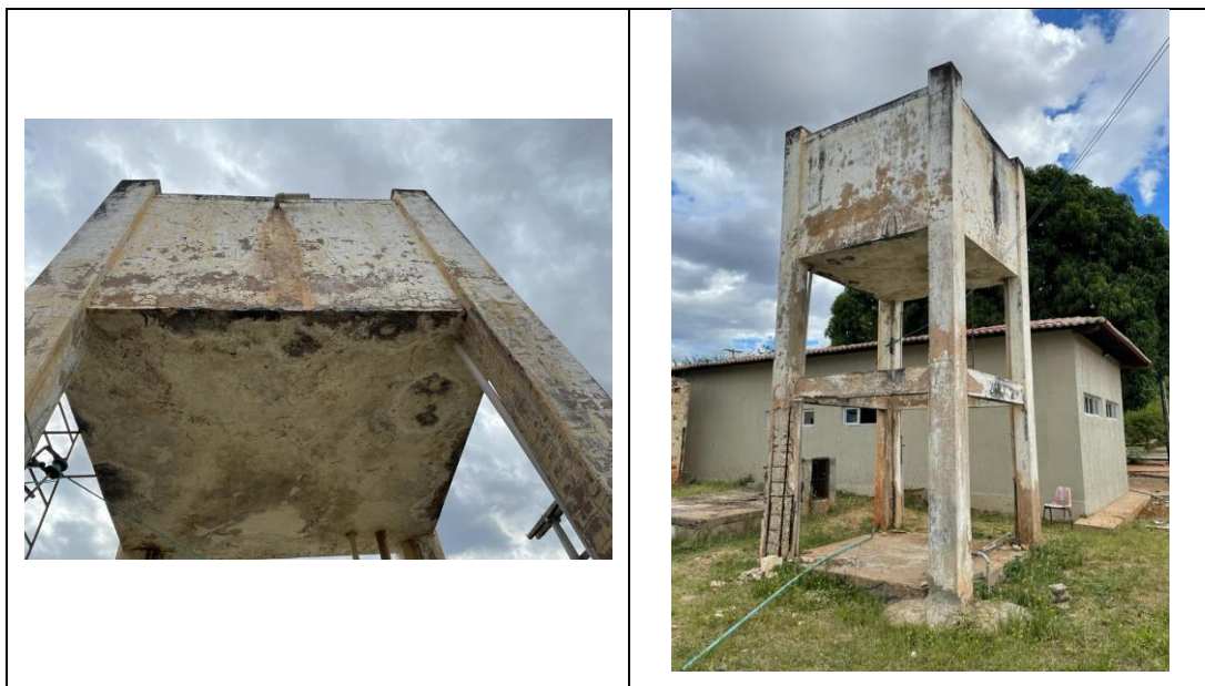
Figura 1 – Manchas de umidade e deterioração do concreto na laje de fundo e paredes do Reservatório.
