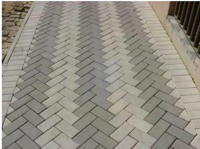
Figura 9 – Calçada com piso intertravado.
