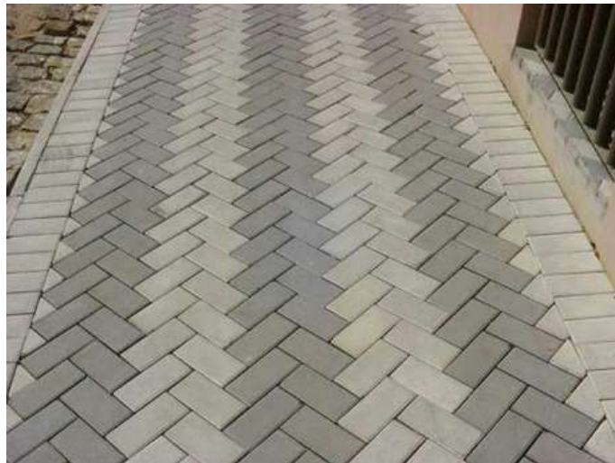
Figura 9 – Calçada com piso intertravado.
