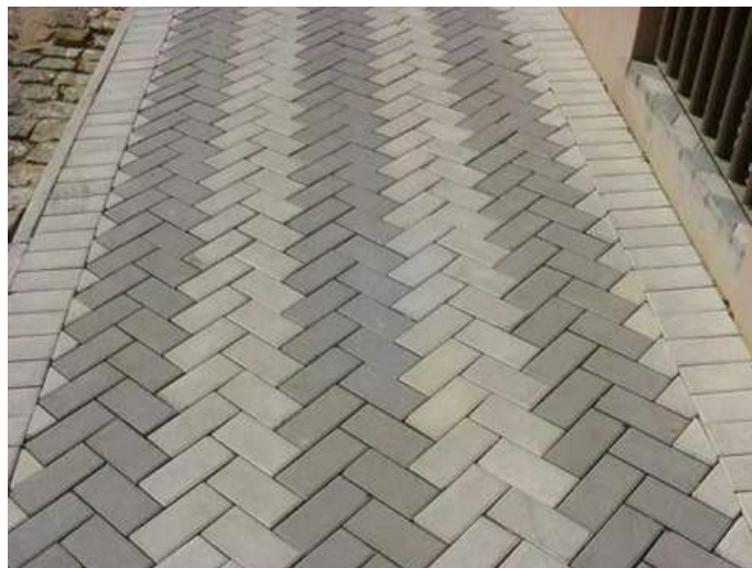
Figura 9 – Calçada com piso intertravado.
