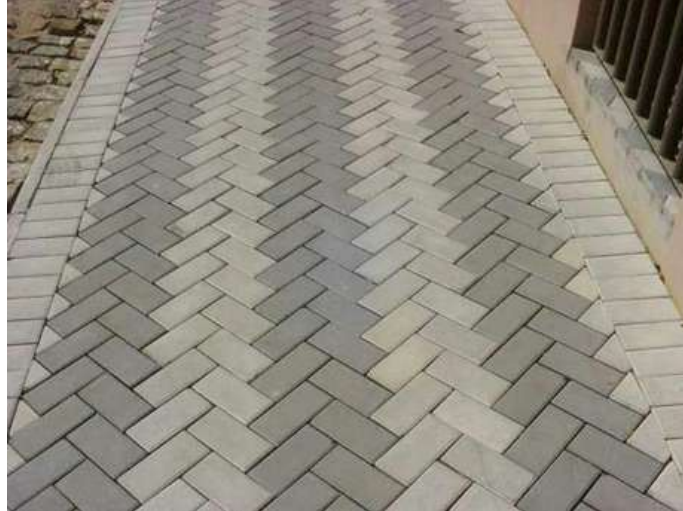
Figura 9 – Calçada com piso intertravado.
