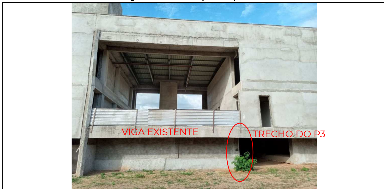
Figura 06 – Execução do pilar P3
