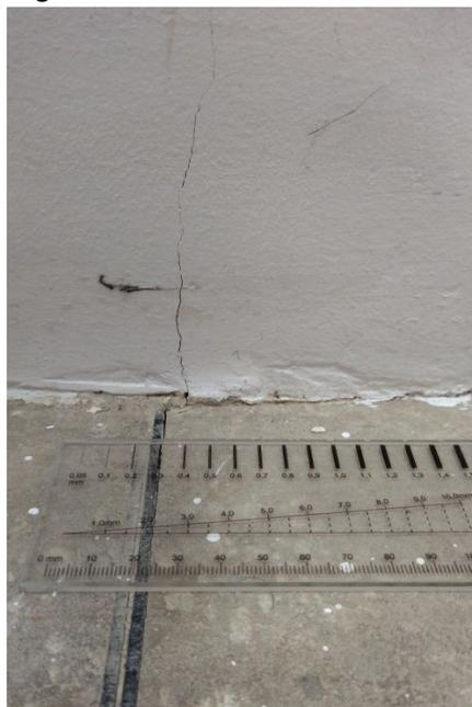
Figura 8: Junta de dilatação do LIT
