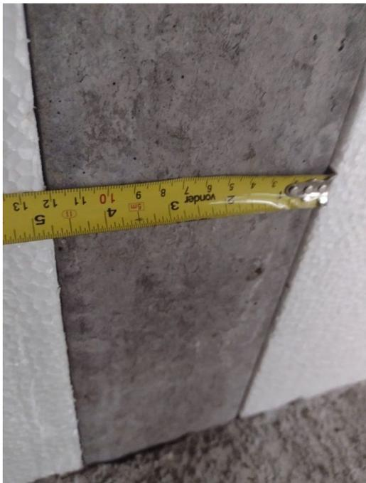
Figura 2: Medição dos vãos com placas de EPS
