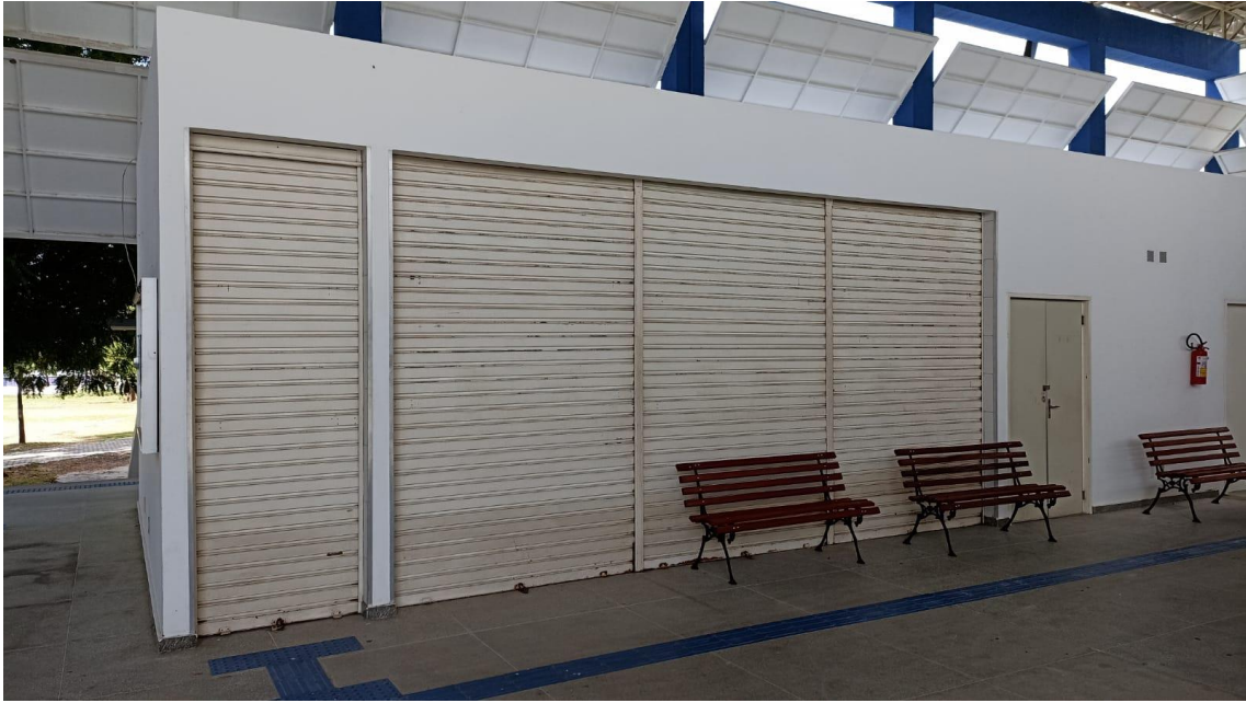
Foto 01 - Fachada da Cantina
