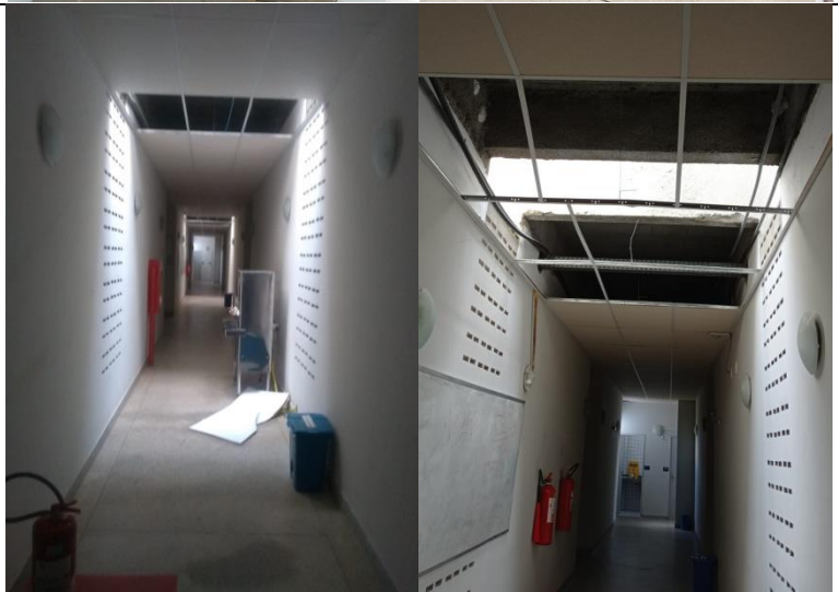
Reposição de placas de forro mineral em vários ambientes.
