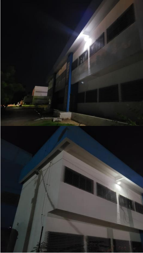
Iluminação atrás do prédio e ao lado da caixa d'água para segurança
