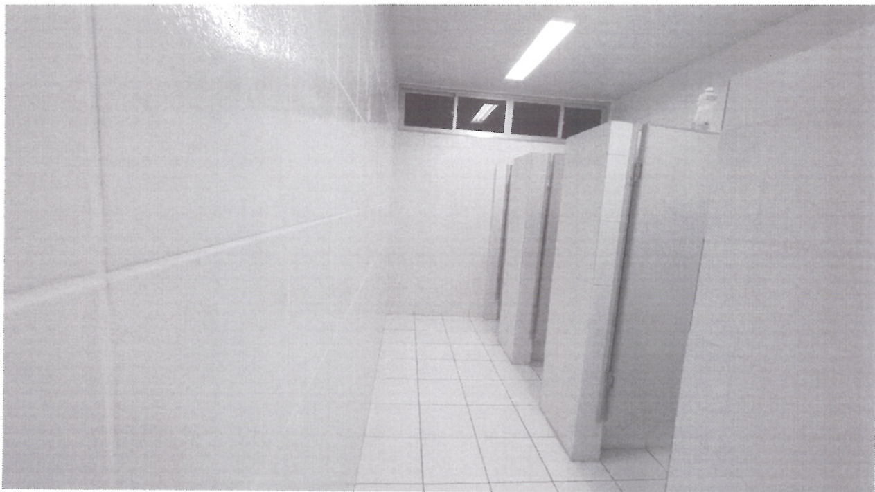
Figura 3 – Espaço em banheiros em que se sugere a reforma para construção de banheiros acessível com base na NBR 9050.
