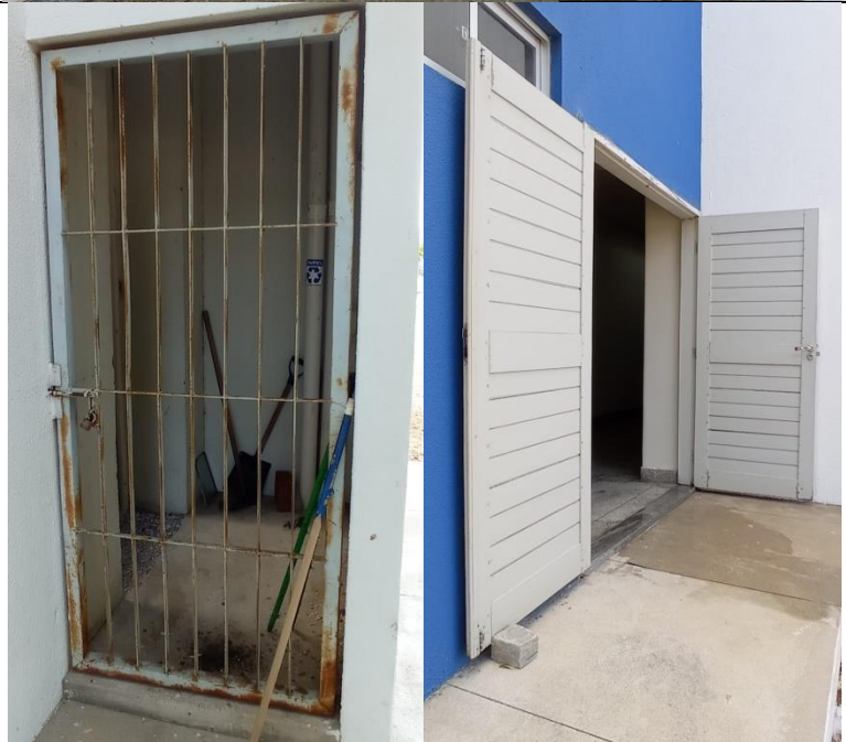
Serviços de pintura de portões de ferro e esquadrias de madeira.
