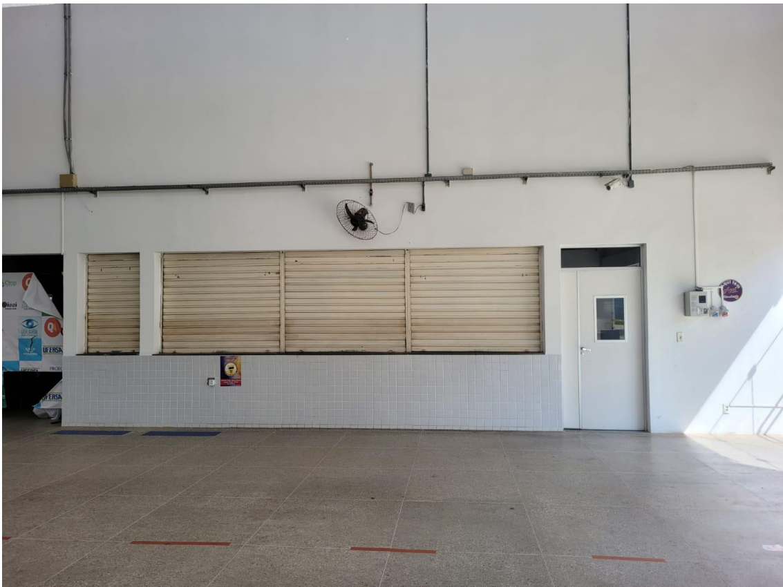
Foto 02 - Fachada da Cantina
