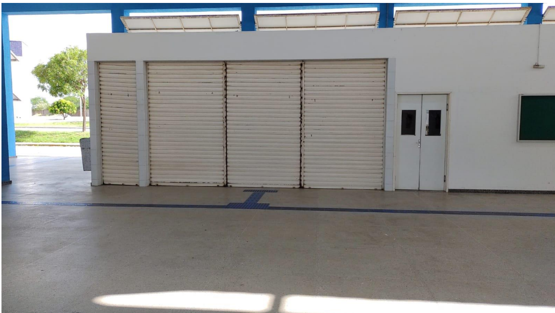
Foto 02 - Fachada da Cantina
