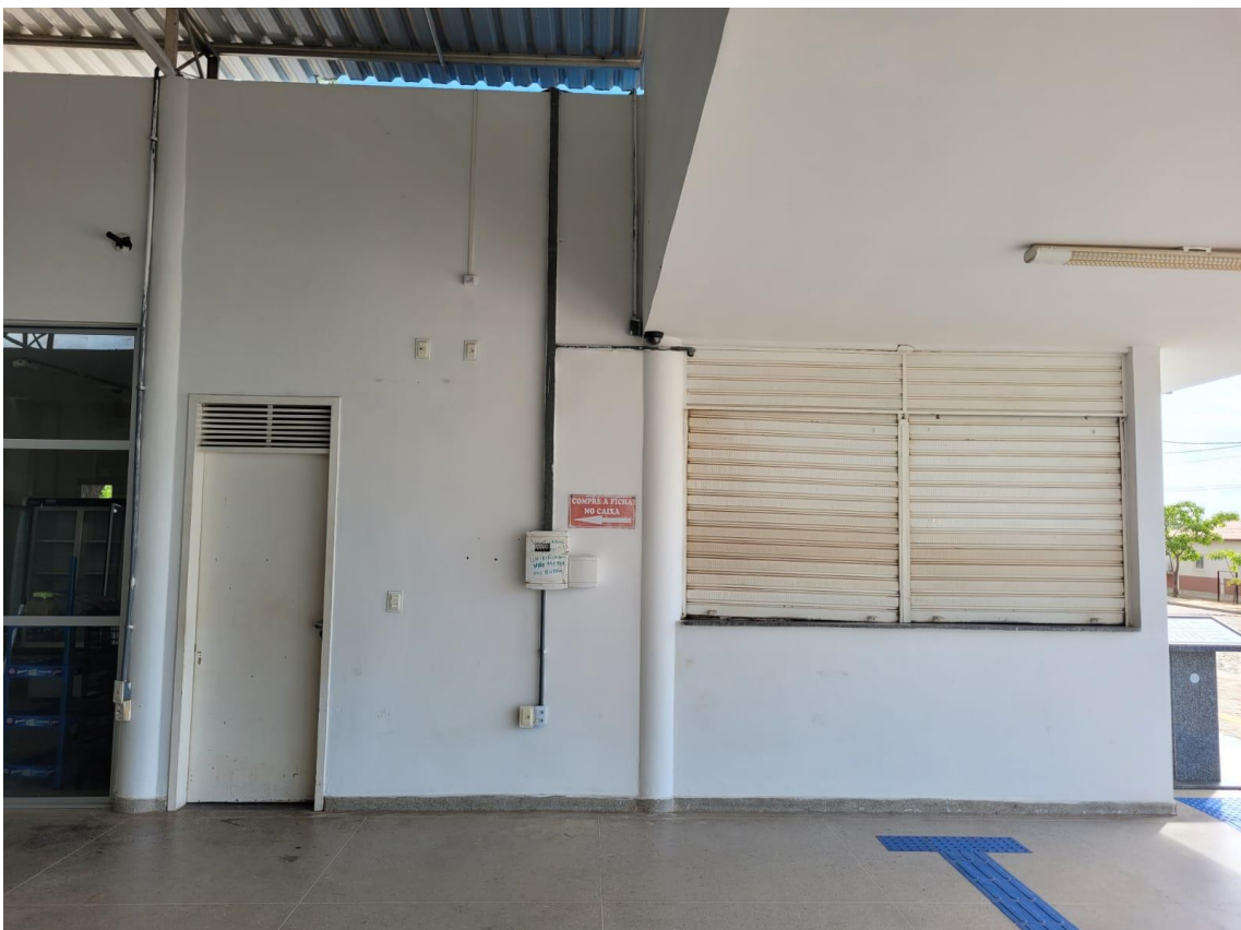
Foto 02 - Fachada da Cantina
