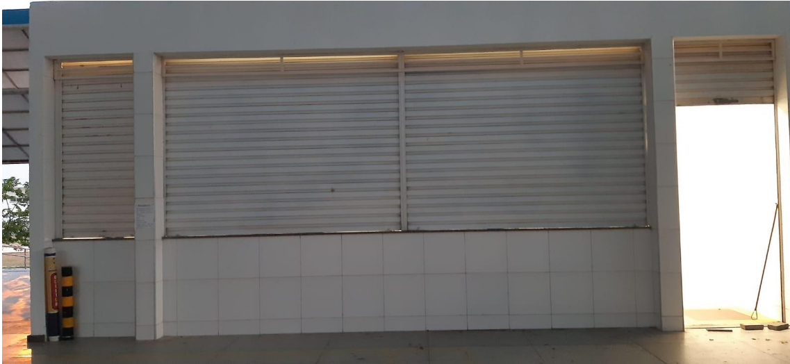
Foto 01 - Fachada da Cantina
