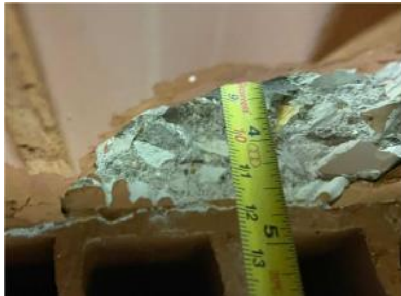
Figura 4: Laje volterrana – Capa mais contrapiso - aproximadamente 11 cm
