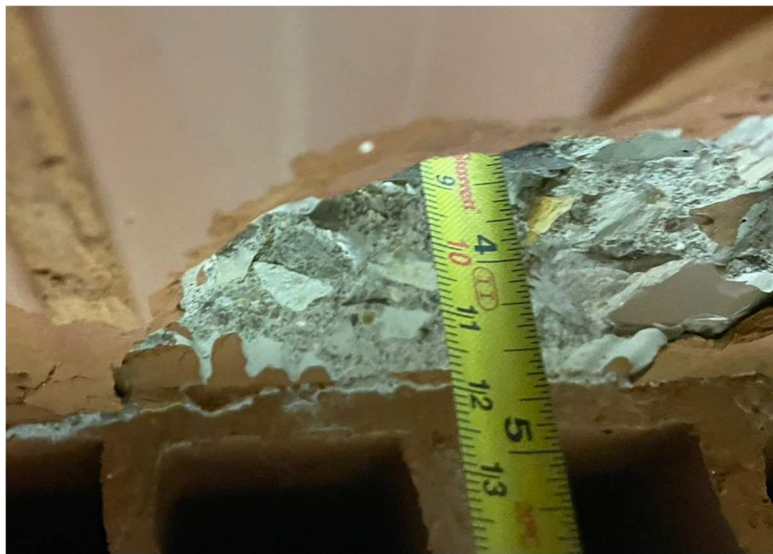
Figura 5 – Laje volterrana – capa + contrapiso (aproximadamente 11 cm)
