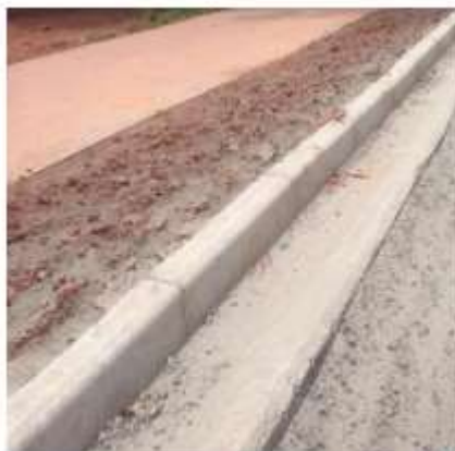
Figura 2 - Execução de guia pré-moldada
