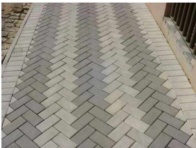
Figura 9 – Calçada com piso intertravado.
