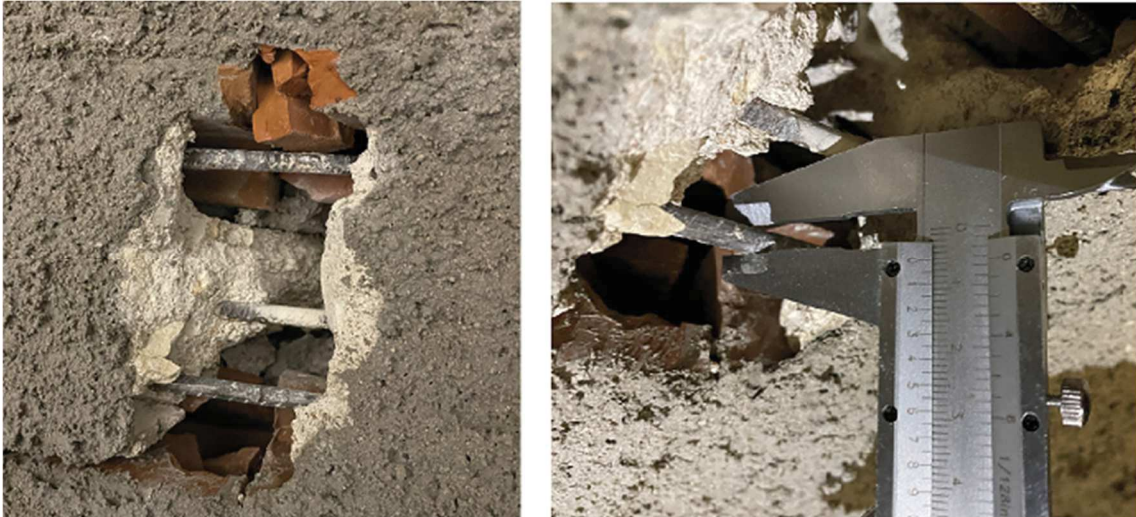
Figura 4 – Laje volterrana - Armação da nervura – 3 ferros de 5.0 mm
