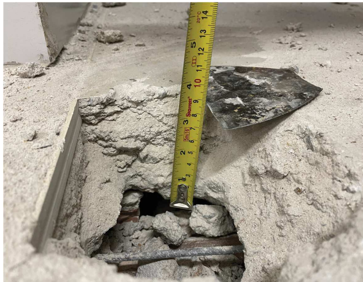
Figura 5 – Laje volterrana – capa + contrapiso
